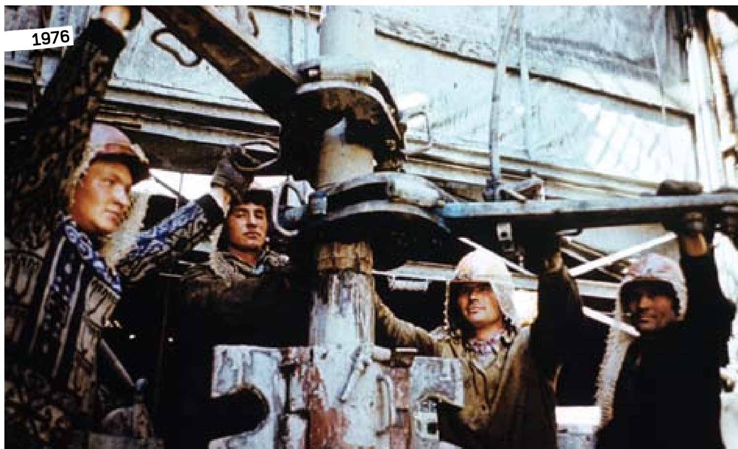
Collegamento dell'asta di perforazione all'interno del pozzo esplorativo okrug autonomo di Yamalo-Nenetsky, Russia, 1976
