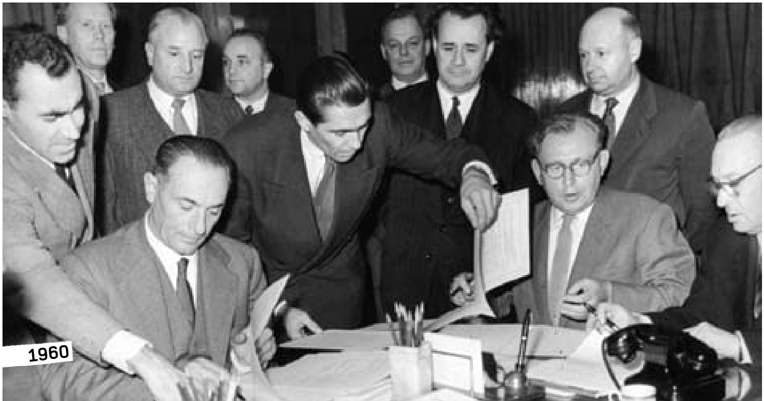
Firma del contratto per la fornitura di greggio Mosca, Russia, 12 ottobre 1960
