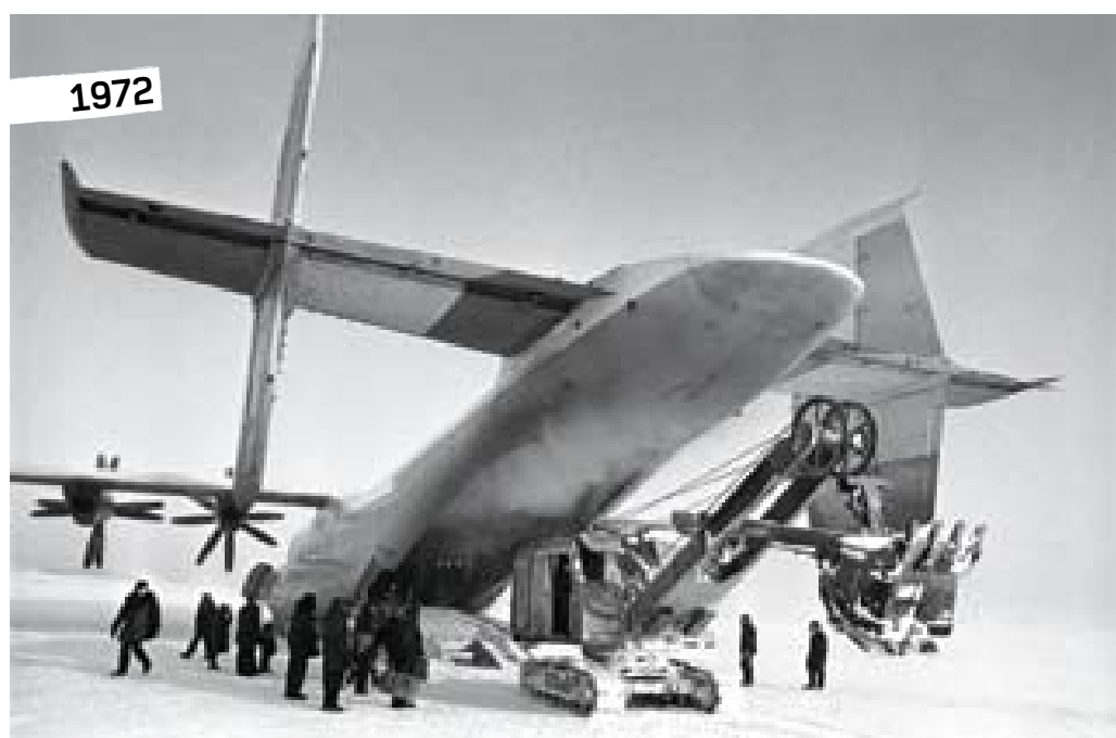
Trasporto di materiale sul sito di costruzione del gasdotto oblast' di Tjumen', Russia, 1972
