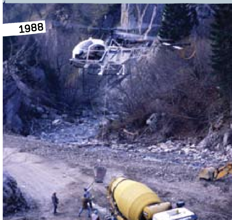
Modernizzazione del gasdotto zona di Pontebba, Italia, 1988
