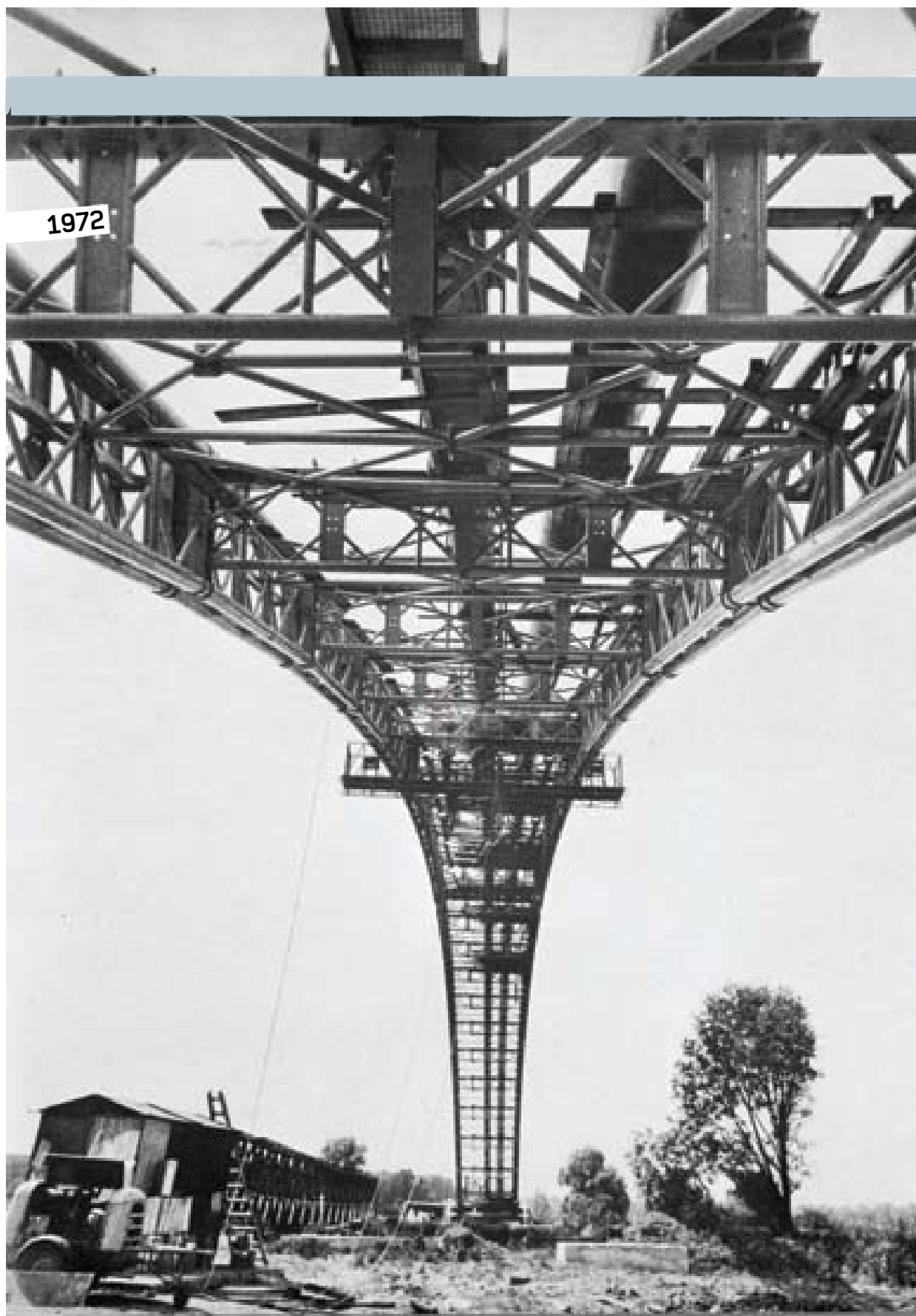
Posa del gasdotto fiume Morava, Slovacchia 1972
