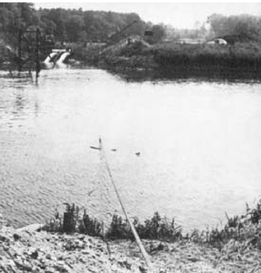
Posa del gasdotto fiume Morava, Slovacchia, 1972
