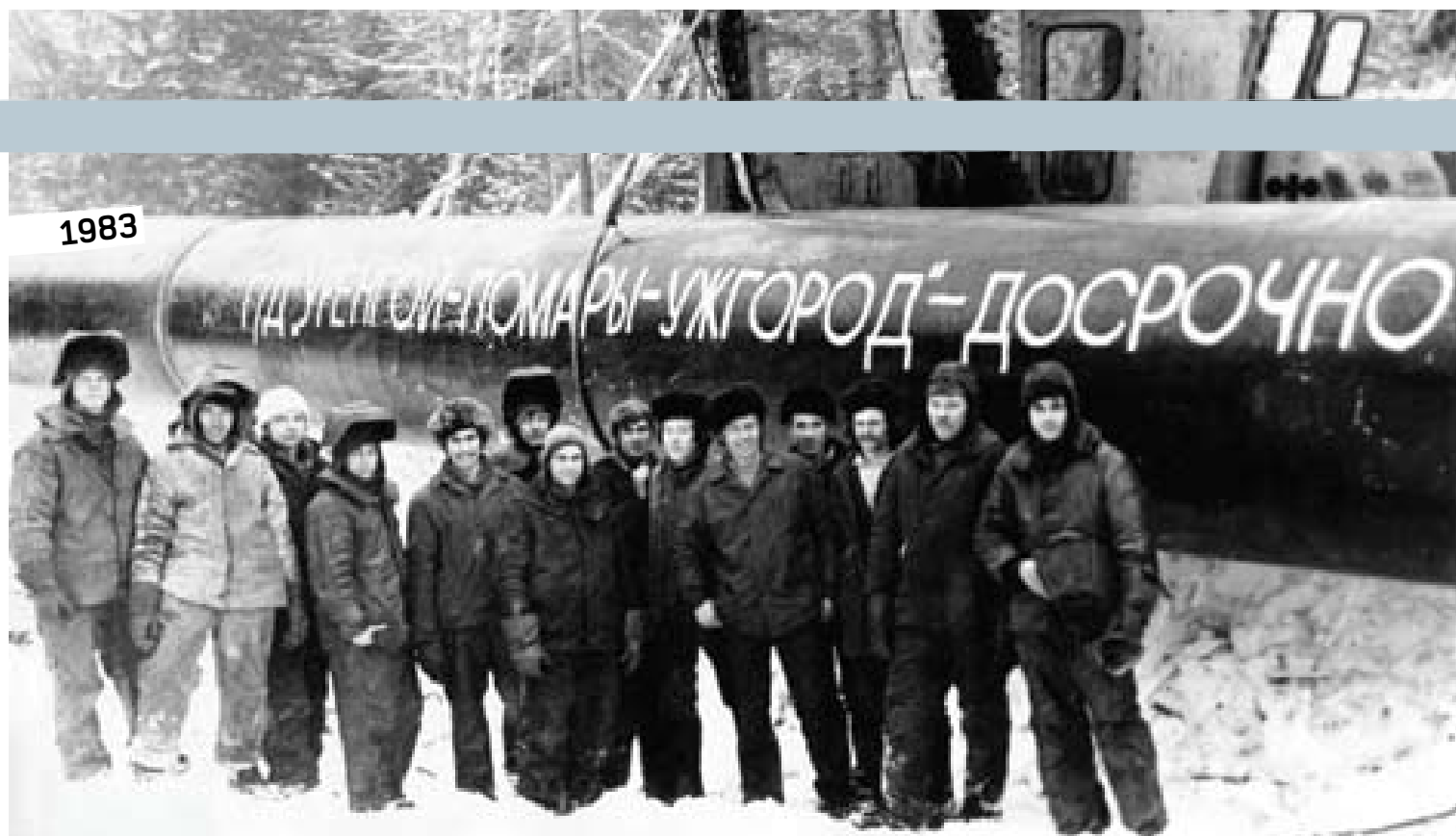
Completamento della costruzione di un tratto del gasdotto Siberia occidentale, Russia, 1983
