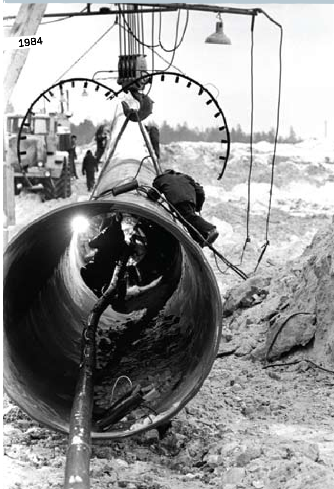
Saldatura del gasdotto oblast' di Tjumen', Russia, 1984
