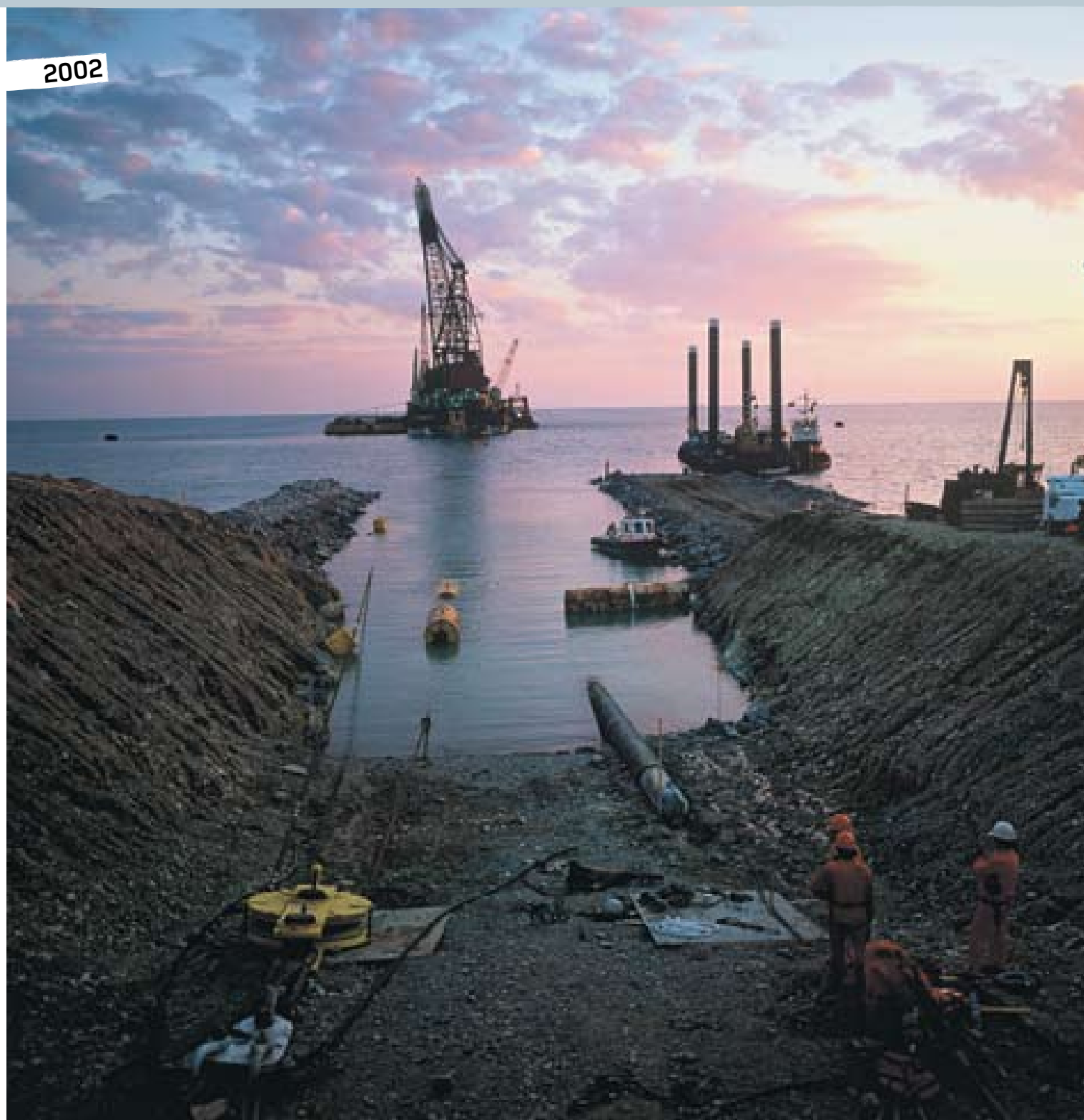
Posa del gasdotto Blue Stream zona di Beregovaya, Russia, 2002
