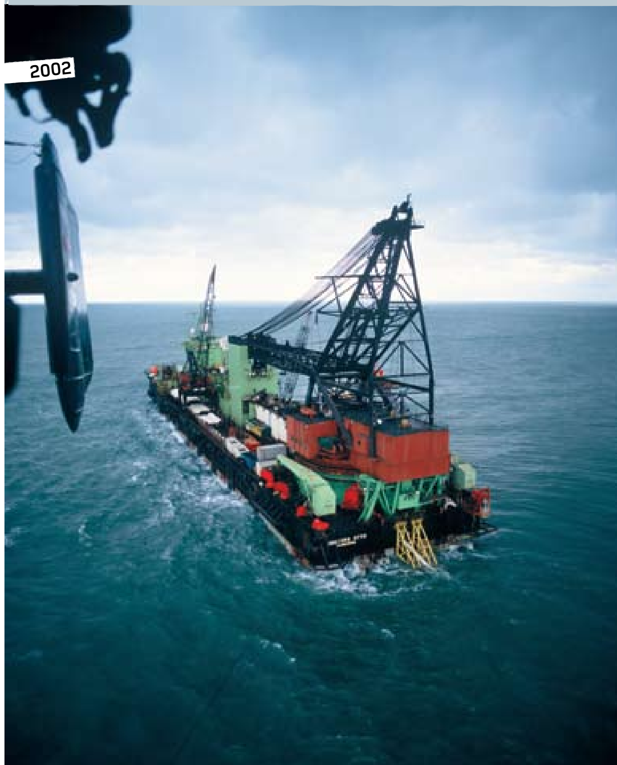
Nave posatubi Castoro 8 impegnata nella posa del gasdotto Blue Stream Mar Nero, Turchia, 2002
