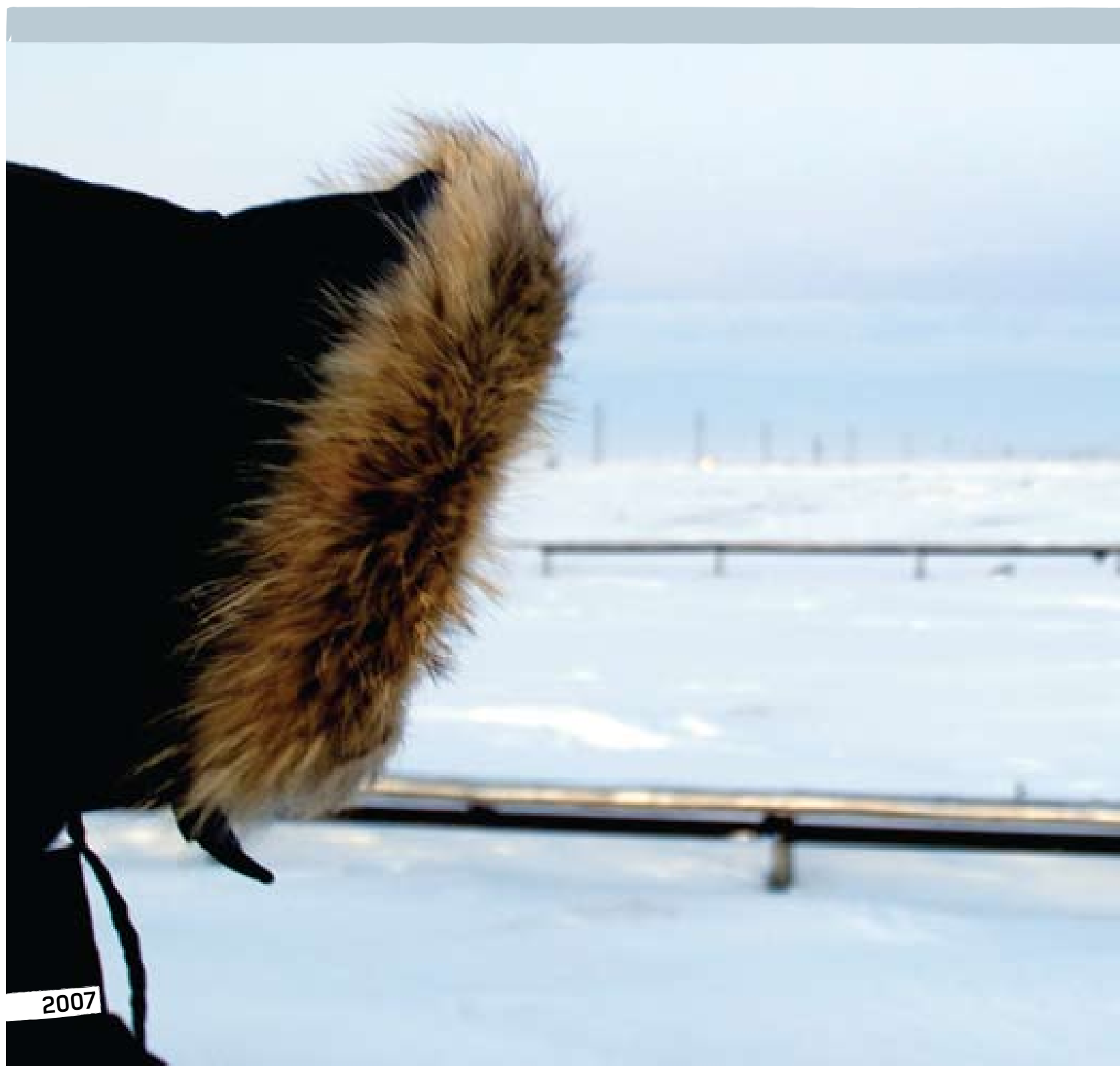
Impianto di produzione e trattamento Novy Urengoy, Russia, 2007
