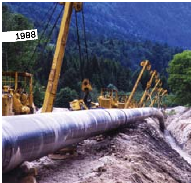
Modernizzazione del gasdotto zona di Tarvisio, Italia, 1988
