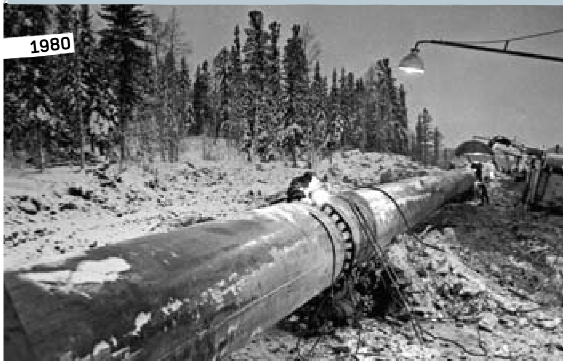
Saldatura del gasdotto oblast' di Tjumen', Russia, 1980
