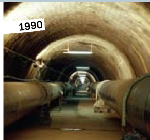
Raddoppio del gasdotto zona di Tarvisio, Italia, 1990c
