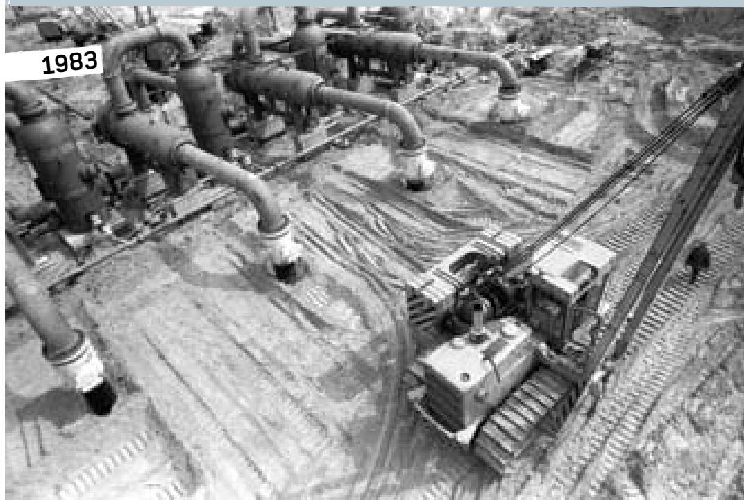
Lavori di montaggio presso la centrale di compressione Repubblica di Mari El, Russia, 1983
