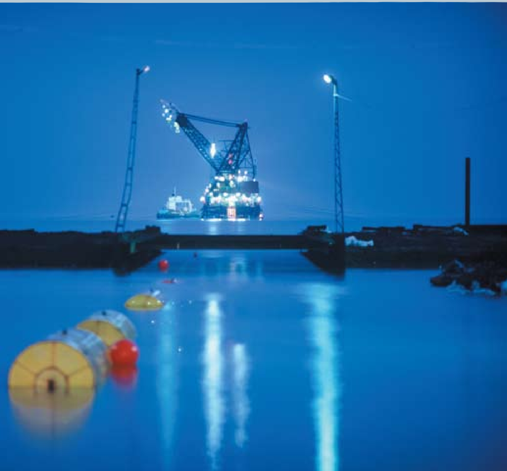
Posa del gasdotto Blue Stream zona di Samsun, Turchia, 2002
