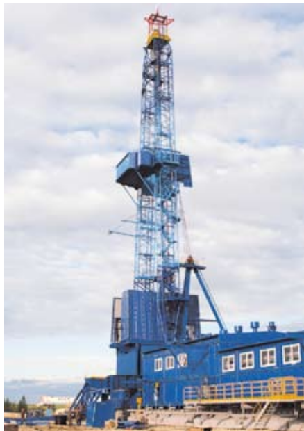
«Yekaterina» Drilling Rig
